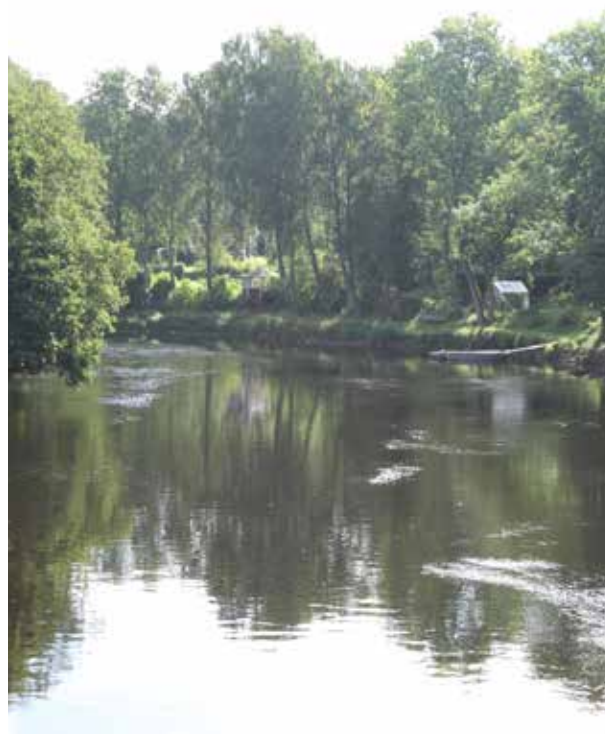
Bild på Lagan. Lagan har översvämmats vid några tillfällen och längs ån finns partier med erosionskänsliga jordarter.
