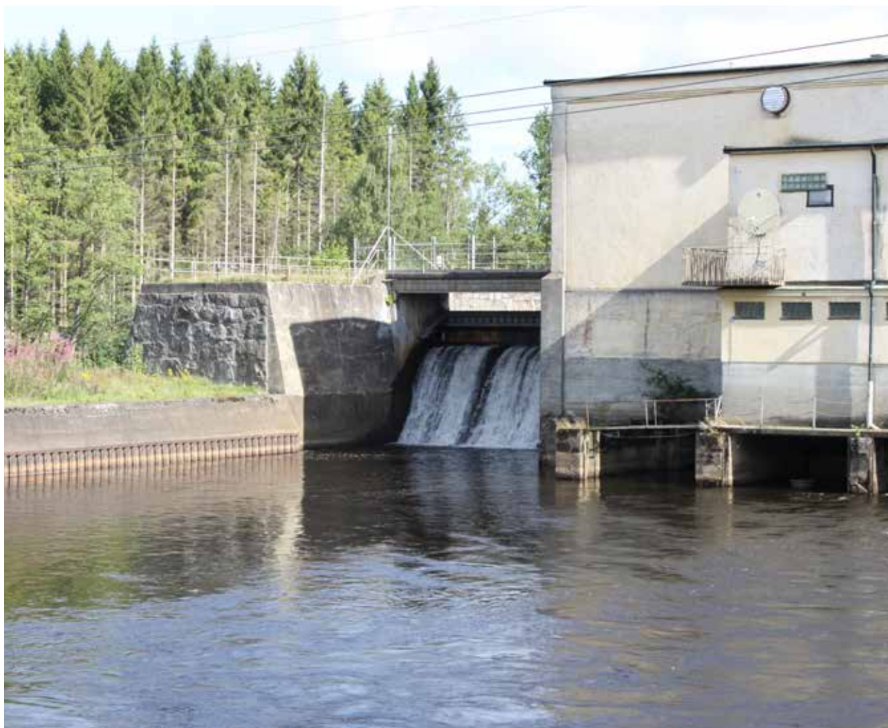
Bild på Timsfors vattenkraftverk, som producerar omkring 13 GWh årligen.
