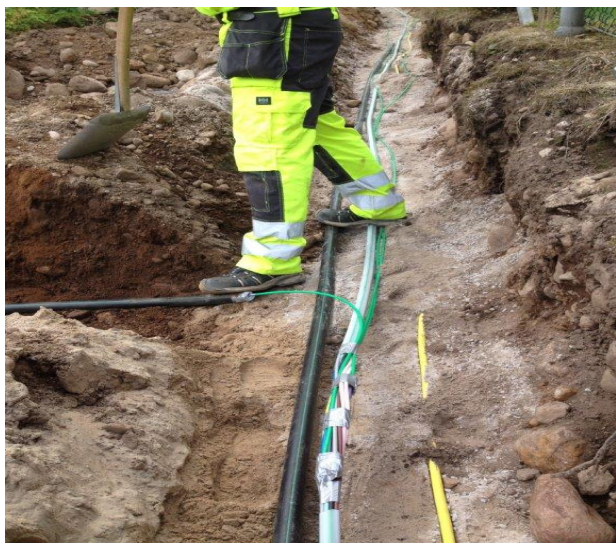
Förläggning av kanalisation för fiber.
