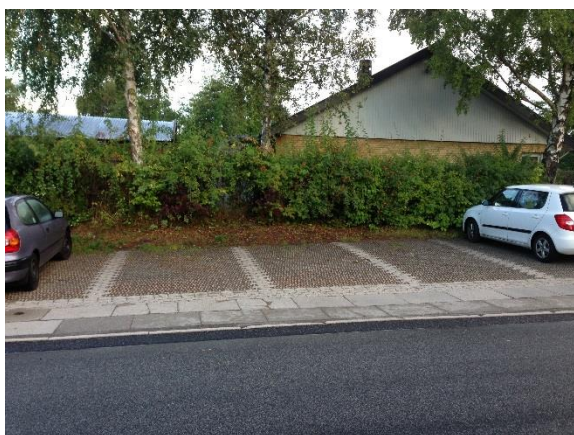
Figur 16. Exempel på permeabel yta.
