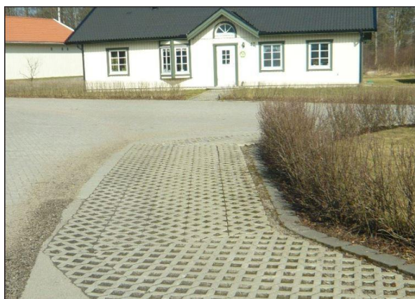
Figur 12. Lösning för parkeringsytor med permeabel körbar yta
