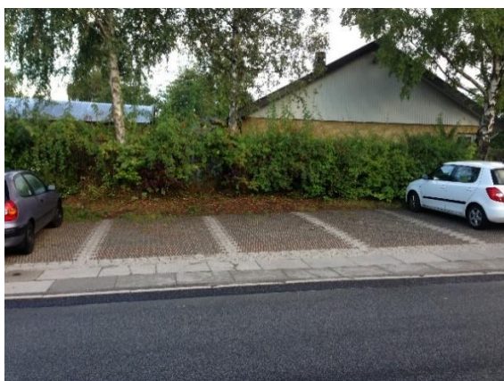
Figur 11. Lösning för parkeringsytor med permeabel körbar yta
