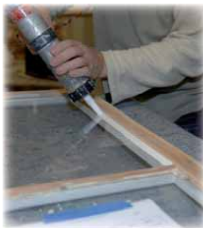
Energiglas monteras och kittas.
