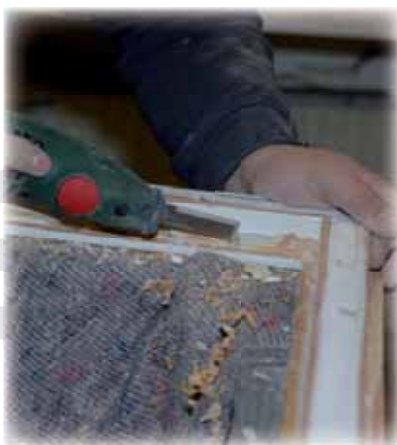
Kitt och glas avlägsnas. Bågen rensas, slipas ren och fuktkontrolleras.
