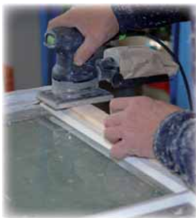
Eventuell träkomplettering, spackling och slipning.
